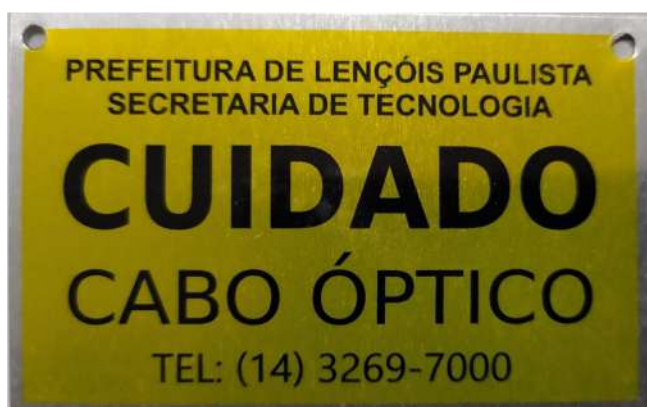
Figura 30: Placa de identificação do cabo óptico
